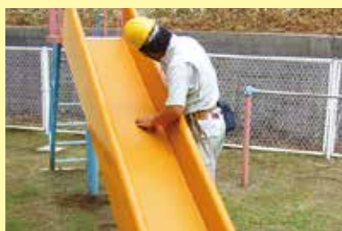
目視・触手により、遊具の劣化状態を診断
