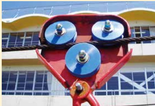
点検の結果に基づき、必要な修繕として、部品交換を行い、完了(ベアリング内蔵のナイロン滑車へ交換)
